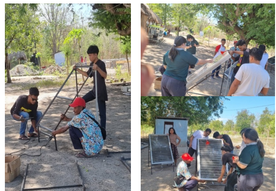
Gambar 3. Pemasangan dan Pelatihan penggunaan Alat Desalinasi
